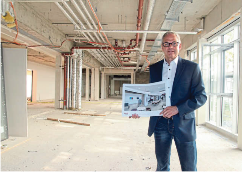
Baustelle: Michael Schelp hofft, dass die Bauarbeiten im Eingangsbereich bis zum Jahresende beendet sind. Und dass sich das Foyer genauso präsentiert wie auf den Plänen.
